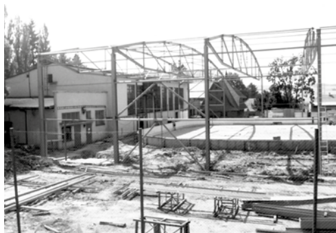
Přimrazovací ledová plocha při zastřešování (vlevo strojovna a sportovní hala). | Zdroj: Archiv TJ Spartak
