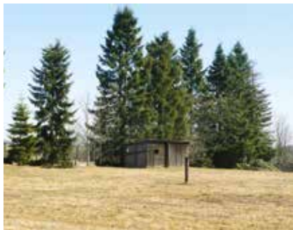
Stavební boudy s částí vystupujících inženýrských sítí na připraveném staveništi smuteční síně z roku 1987. | Foto: Alois Koukola
