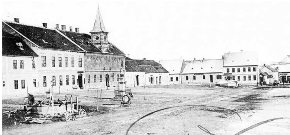
Náměstí a kašny při stavění zimního bednění okolo roku 1900. Výjev z dobové pohlednice.
