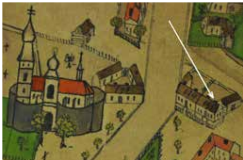
Bývalý dům čp. 195 na sklonku 19. století.
