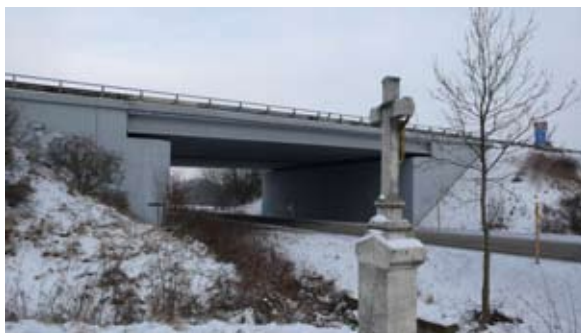
Dálniční most přes jindřichovskou silnici.
