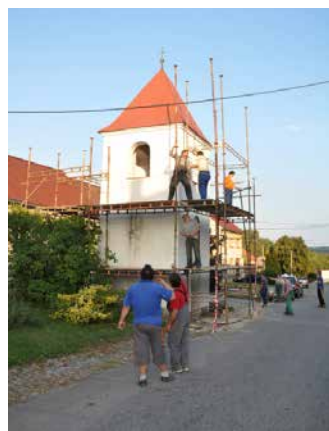
Oprava zvoničky. | Foto: Archiv obce
